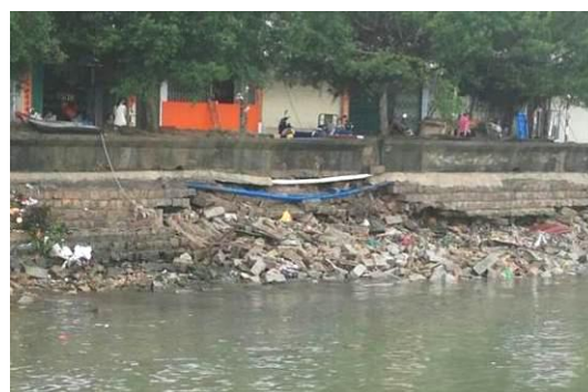
图 9 汕尾市城区护岸受破坏
