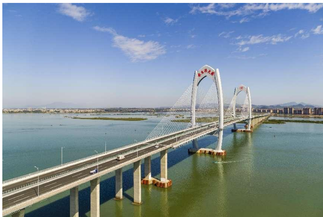
图 1-11 茂名水东湾大桥建成通车
