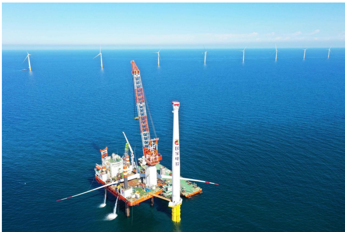
图 1-9 国家电投湛江徐闻 60 万千瓦海上风电项目
